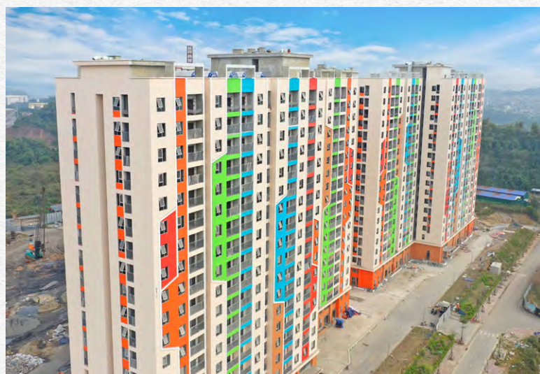
Hình ảnh tiến độ Dự án Nhà ở xã hội Golden Square Lào Cai cuối năm 2025
